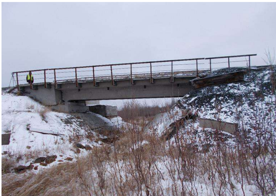
Рисунок 20.1 – Общий вид моста 2019 г.
