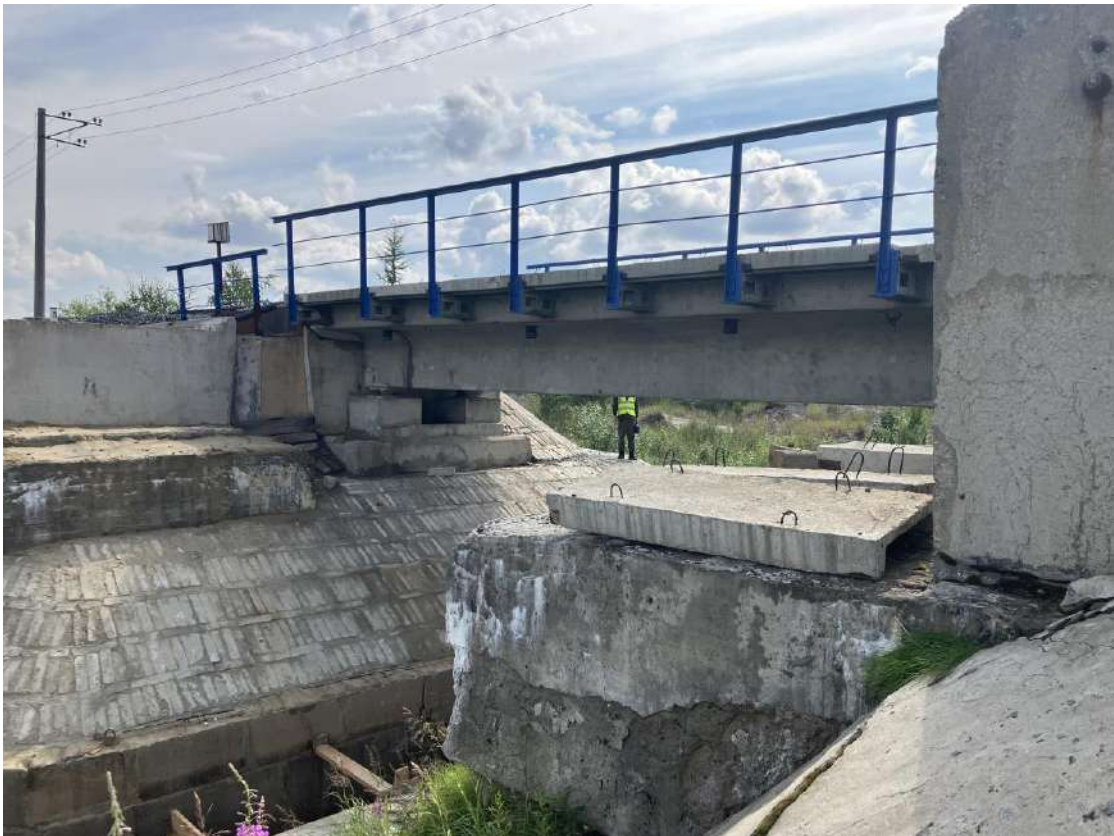
Рисунок 20.2 – Общий вид моста 2024 г.
